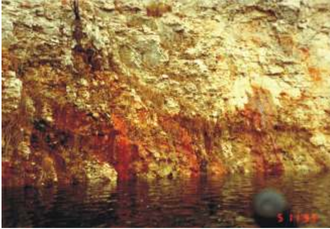
Fig. 17. Rodkowa cz północnej ciany kamieniołomu „Zakrzówek”, w pobliżu wycieków nr 1 i 17
