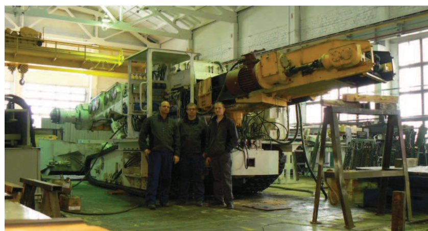
Instalacja systemu SUK-2 w kombajnie chodnikowym URAL-320U (Kopiejsk, Rosja) Установка системы SUK-2 в проходческом комбайне УРАЛ-320 У (Копейск, Россия)
