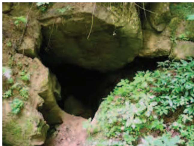
Fig. 14. Otwór wejściowy sztolni w Potoku Pałkowskim, fot. T. Bartuś • Entrance to the Pałkowski stream adit, phot. T. Bartuś
