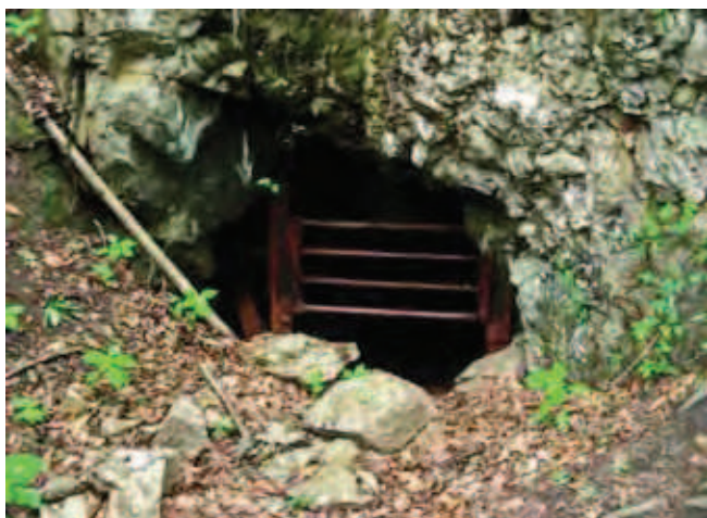
Fig. 11. Otwór wejściowy sztolni w Jarmucie, fot. T. Bartuś • Entrance to the Jarmuta adit, phot. T. Bartuś
