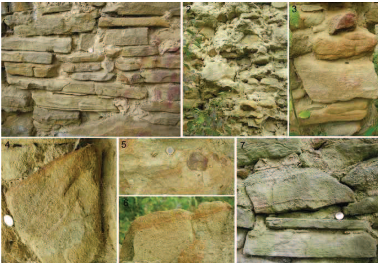
Fig. 17. Piaskowce istebniańskie w murach ruin zamku rycerskiego Rożnów zbudowanego na wychodniach piaskowców istebniańskich dolnych, fot. A. Waškowska. 1 – fragment muru zbudowany z droбно- i średnioziarnistych piaskowców płytowych z zachowaną laminacją równoległą, a miejscami i przekątną (na lewo od monety 1 €); 2 – fragment muru z nieregularnych fragmentów łamanego piaskowca; 3 – fragmenty gruboławicowych gruboziarnistych i zlepieńcowatych piaskowców z słabo zaznaczoną laminacją; 4 – gruboziarnisty piaskowiec z laminacją przekątną; 5 – piaskowiec gruboziarnisty z klastami piaskowców o spoiwie krzemionkowo-żelazistym; 6 – piaskowiec zlepieńcowaty z żelazistymi pierścieniami wietrzennymi Lieseganga; 7 – gruboziarnisty piaskowiec frakcjonalnie uziarniony ze słabo widoczną laminacją (nad monetą) i piaskowce płytowe poniżej.
