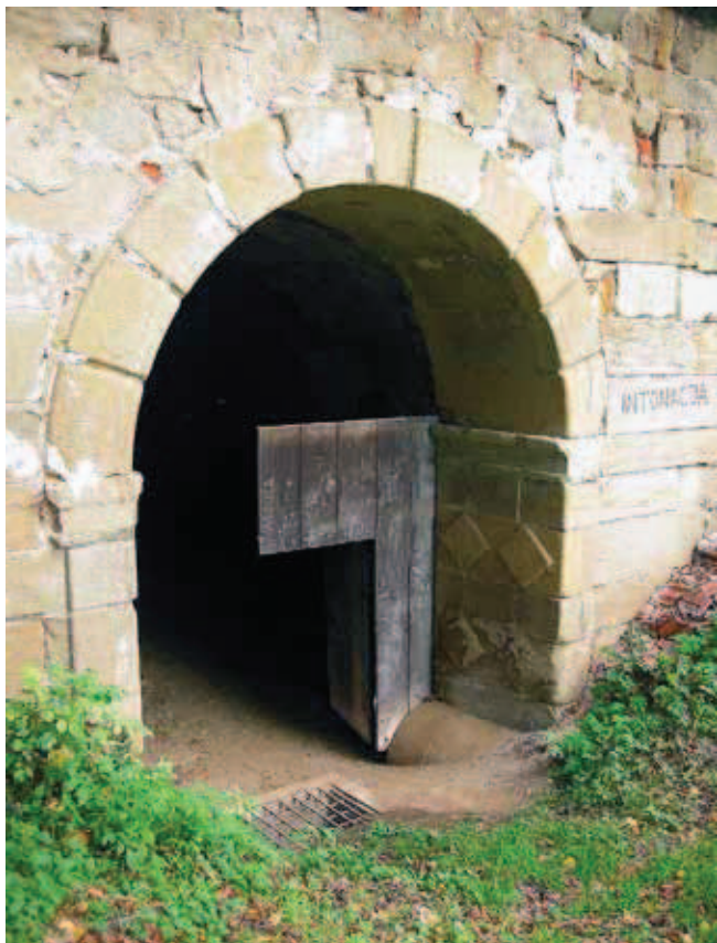
Fig. 10. Brama wjazdowa do Nowego Zamku w Rożnowie, fot. A. Waškowska • Gate of the New Rożnow Castle, phot. A. Waškowska
