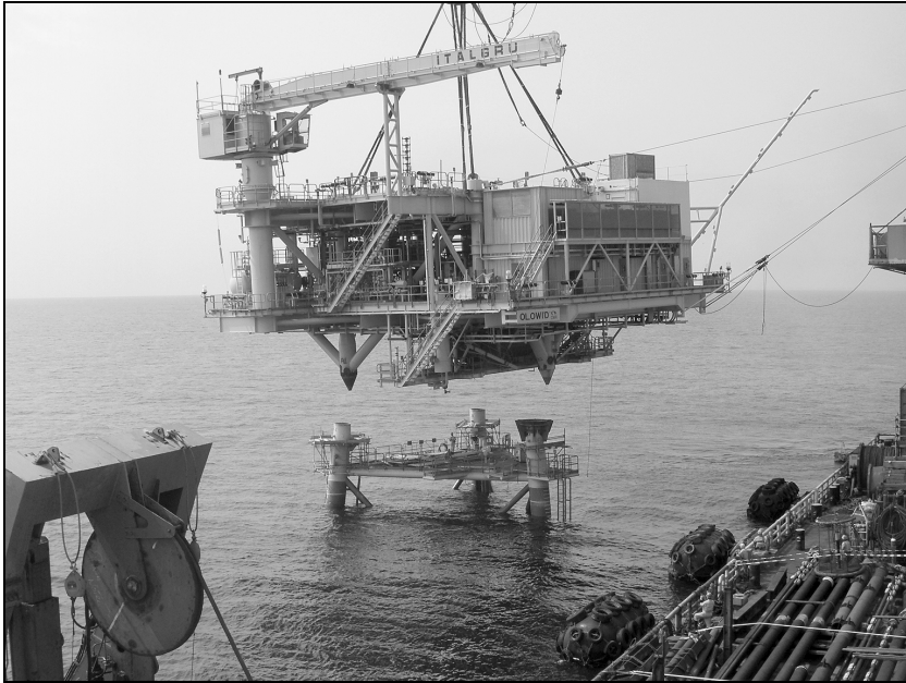
Rys. 1. Budowa nowej platformy wiertniczej (fot. Arkadiusz Tomczak)
