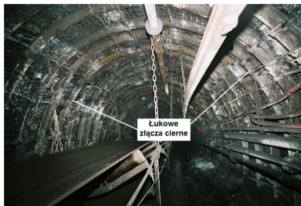
Rys. 1. Odrzwia obudowy podatnej z łukowymi złączami ciernymi
