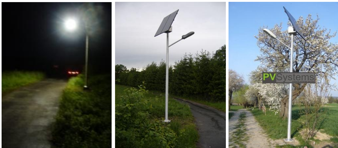
Rys. 3. Przykład wykorzystania systemu fotowoltaicznego do zasilania oświetlenia zewnętrznego lampami typu LED
