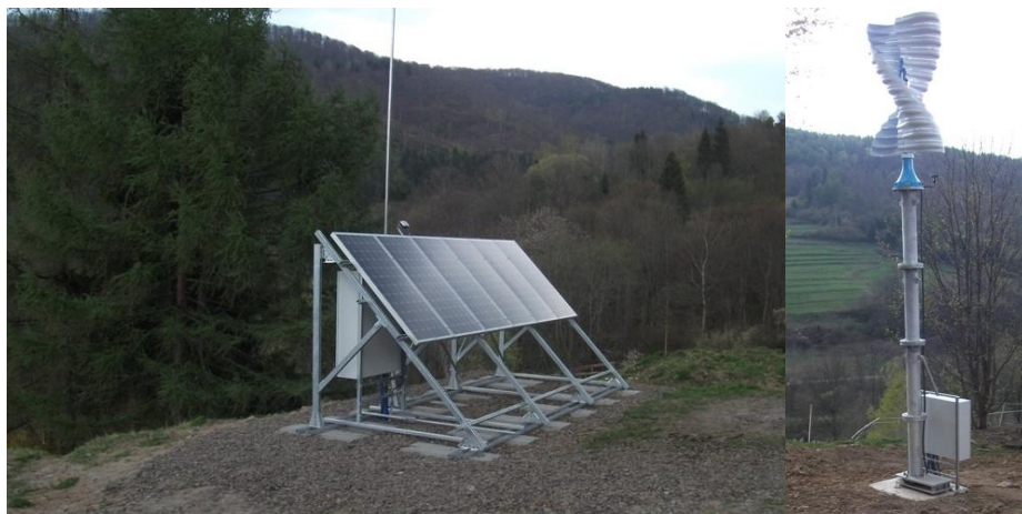
Rys. 4. Przykład hybrydowego systemu zasilania schroniska
