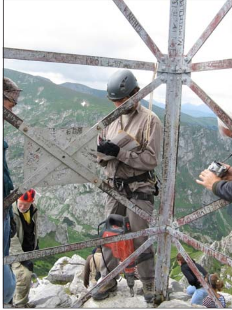
Rys. 7. Wiercenie otworu badawczego 1 w fundamencie krzyża. Fot. I. Wąs
