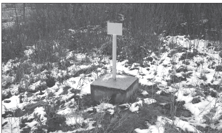
Rys. 2. Cementowy cokolik oraz tabliczka z numerem zlikwidowanego odwiertu
