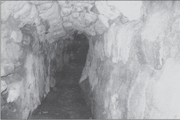
Rys. 2. Widok kanału blokowego [3, 4]
