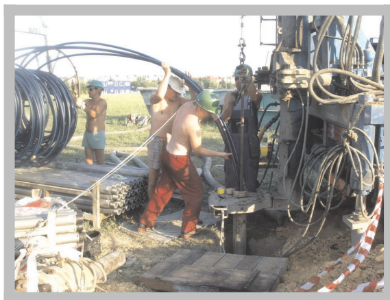
Rys. 5. Zapuszczanie rurek kolektorowych 32 mm wraz kolumną do iniektowania otworu oraz zestawami czujników
