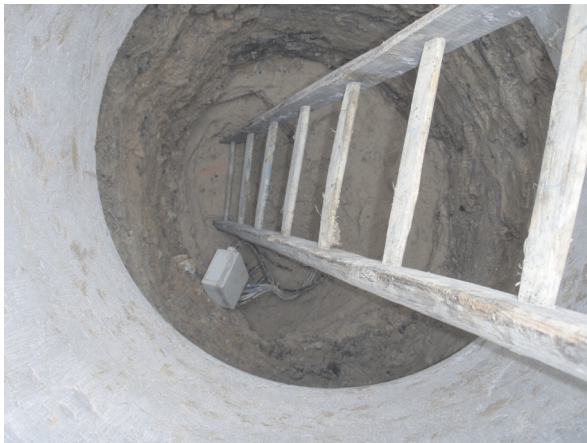
Rys. 10. Widok na odkopaną skrzynkę w szybiku otworu VO71
