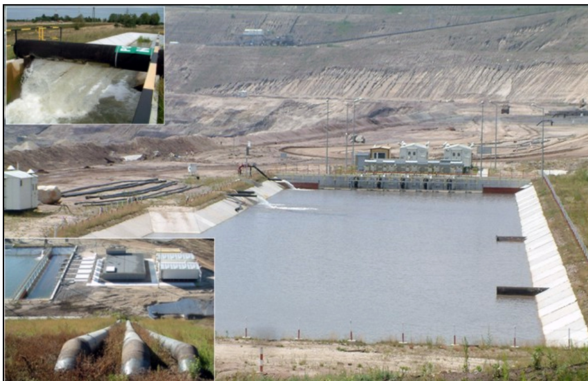
Rys. 12. Pompownia z pompami zatapialnymi OZ-400W [7]
