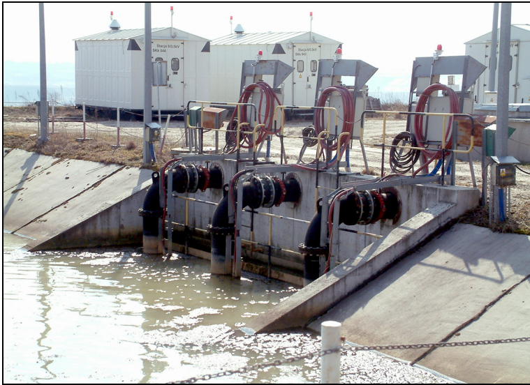
Rys. 11. Pompownia z trzema pompami zatapialnymi OZ-400 [7]
