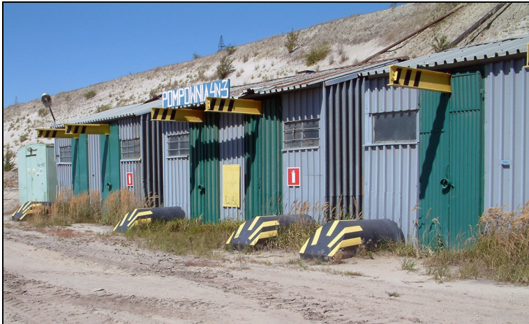
Rys. 1. Pompownia stała z budynkami stalowymi [7]
