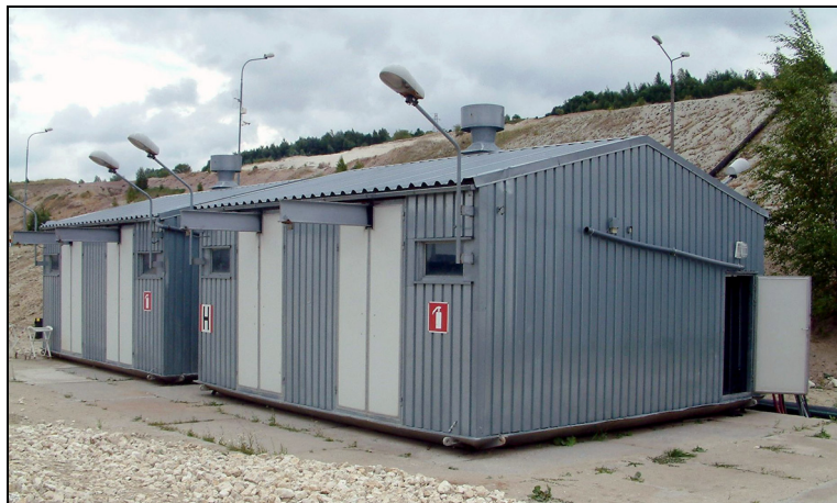
Rys. 3. Stalowe budynki pompowni o konstrukcji przesuwnej [7]
