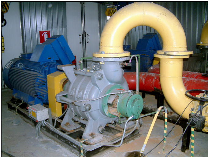
Rys. 8. Zmodernizowany zespół pompy OS-250AM/3 bez układów chłodzenia i smarowania olejowego [7]
