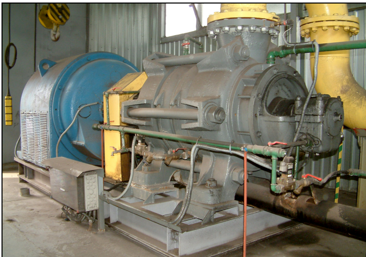
Rys. 6. Zespół pompy OW-300AM/3 z układami chłodzenia i smarowania olejowego [7]
