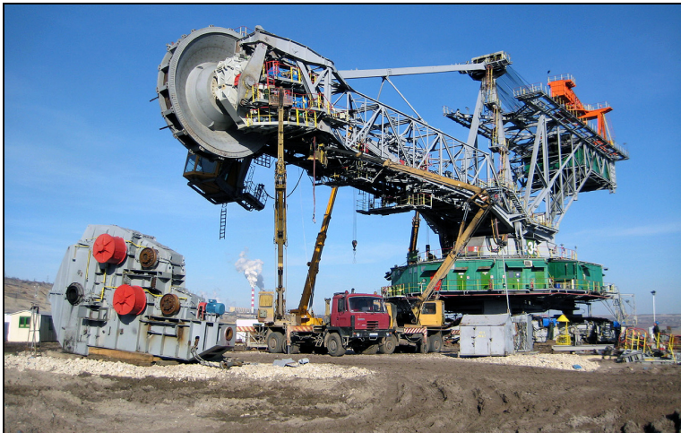
Rys. 10. Montaż nowego zespołu koła czerpakowego (na dole stara przekładnia)
