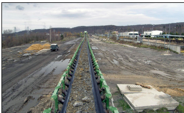
Rys. 6. Zasypana wyrwa i odbudowany ciąg ON-3
