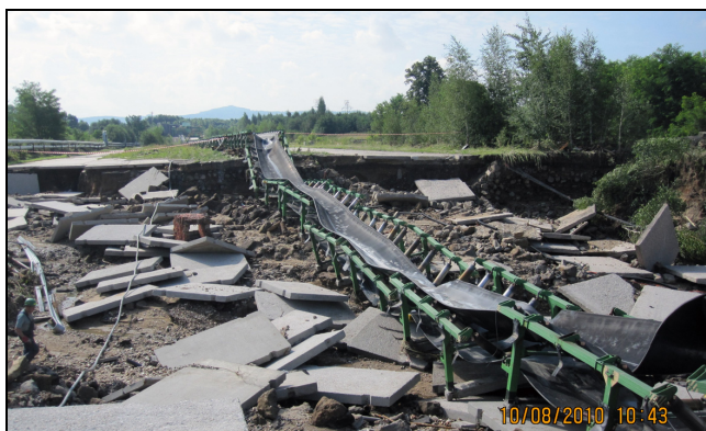
Rys. 5. Wdarcie się wody do odkrywki w rejonie ciągu ON-3
