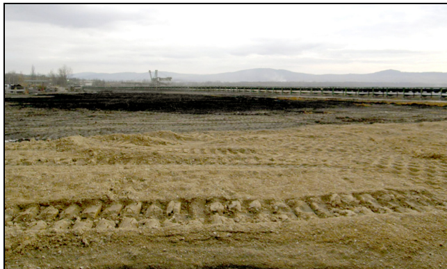
Rys. 4. Zasypana wyrwa i odbudowany ciąg ON-1
