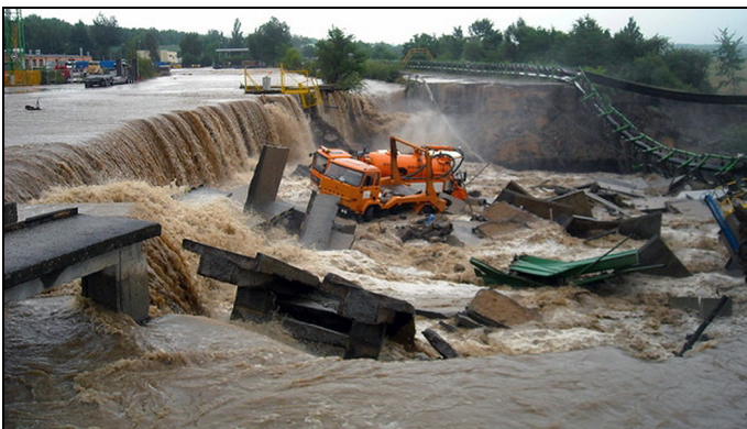
Rys. 3. Wdarcie się wody do odkrywki z rzeki Miedzianki w rejonie bazy transportowej i przerwanie ciągu ON-1
