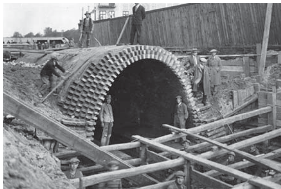
Rys. 2. Budowa kanału w Łodzi metodą odkrywkową [9]
