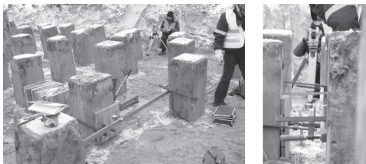
Rys. 8. Stanowisko do badań nośności bocznej pali prefabrykowanych
