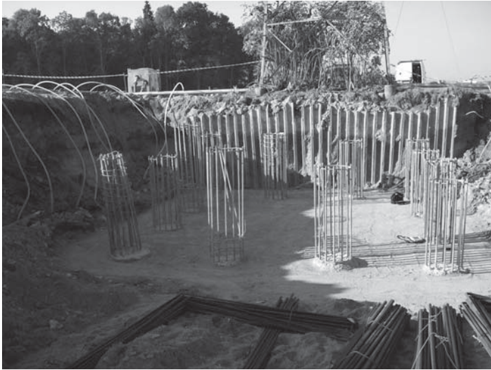
Rys. 1. Widok poletka badawczego — przygotowane głowice pali
