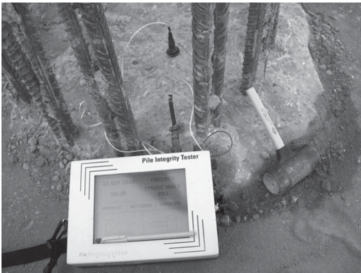
Rys. 2. Pile Integrity Tester — głowica pala przygotowana do badań
