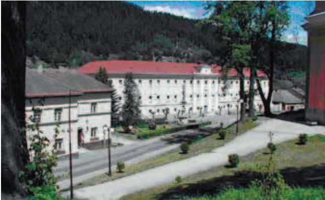
Fig. 9. The Kamerhof – the former seat of court chamber at Smolník destroyed by fire in 1880 and reconstructed into tobacco factory, photo T. Sasvári • Kamerhof – dawna siedziba sądu w Smolniku zniszczona przez pożar w roku 1880 i przebudowana na fabrykę tytoniową, fot. T. Sasvári
