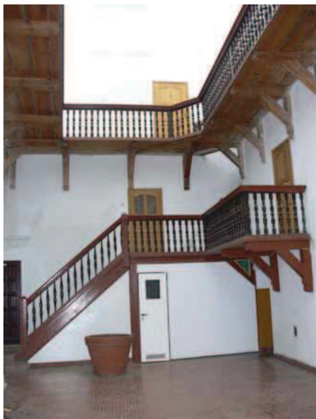
Fig. 25. Charakterystyczna sień w kamienicy jarosławskiej, fot. M. Doktor • Typical vestibule of Jarosław house, phot. M. Doktor
