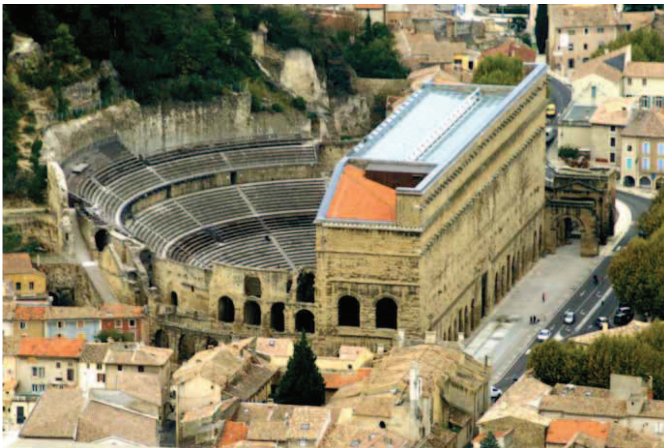
Fig. 5. Imponująca konstrukcja teatru rzymskiego w Orange z widownią wykuta w skale • Impressive Roman theatre in Orange with the auditorium hollwed out in the hillside
