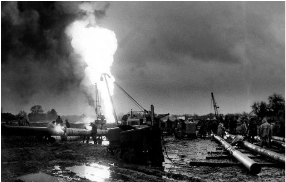
Rys. 1. Widok terenu wiertni „Daszewo-1” w trakcie trwania akcji ratowniczej [5]
