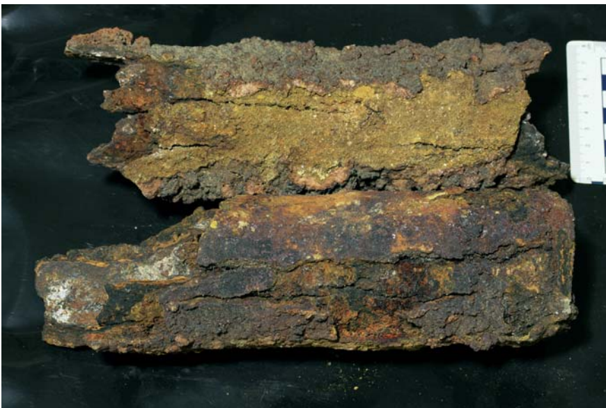
Fig. 3. Skorodowane fragmenty orurowania kopalni
