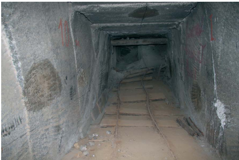
Fig. 11. Chodnik na poziomie II niższym wykonany wrębiarką firmy Demag (fot. W. Wiewiórka)
