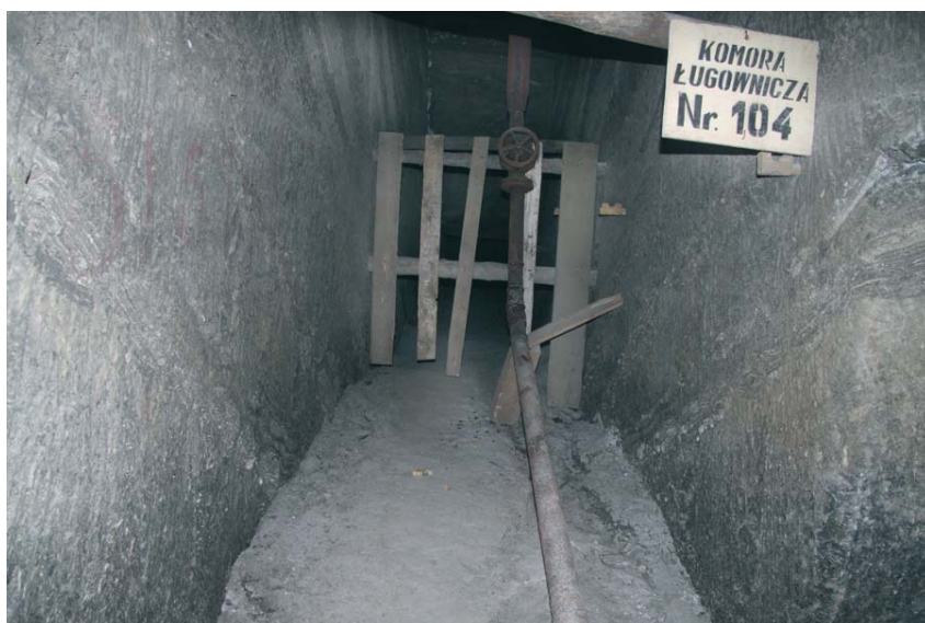
Fig. 15. Odpływ z komory ługowniczej W-104 (fot. W. Wiewiórka)
