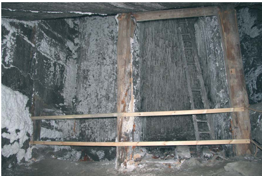
Fig. 17. Podszybie szybiku Franciszek na poziomie III (fot. W. Wiewiórka)
