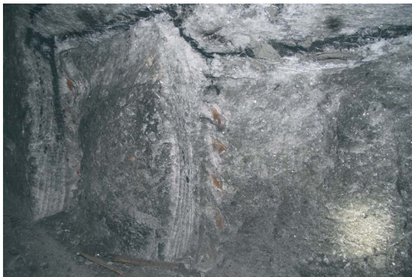
Fig. 12. Ocios komory przy poprzeczni Lipowiec 1 z widocznymi śladami po metalowych klinach (fot. W. Wiewiórka)
