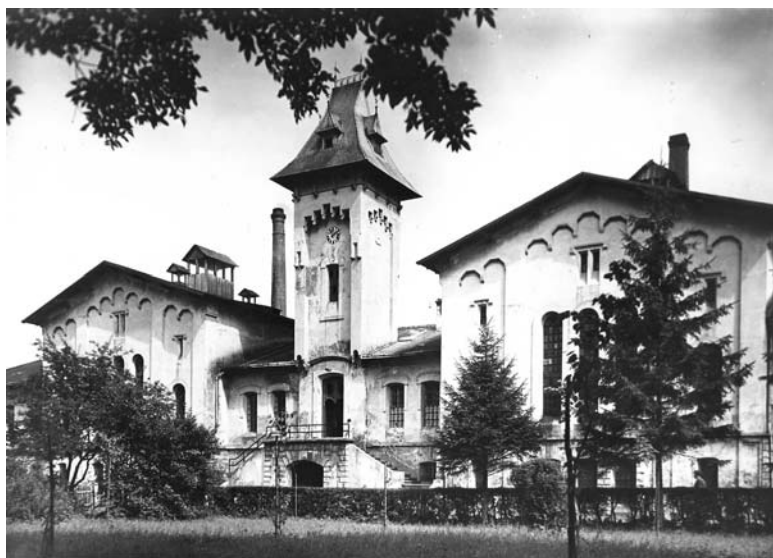
Fig. 7. Widok na budynki kopalni w Stebniku (ze zbiorów prof. J. Poborskiego)
