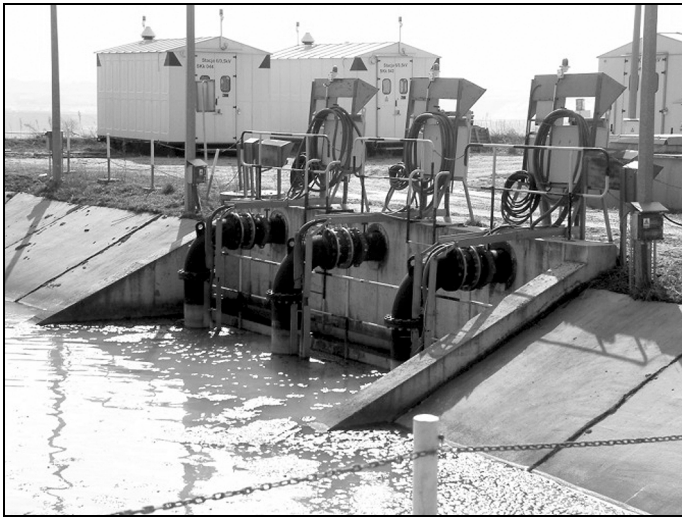
Rys. 14. Pompownia z trzema pompami zatapialnymi OZ-400 [6]
