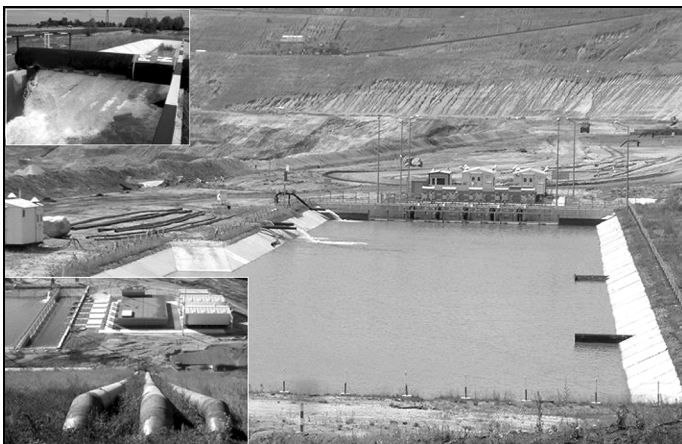
Rys. 15. Pompownia z pompami zatapialnymi OZ-400W [6]
