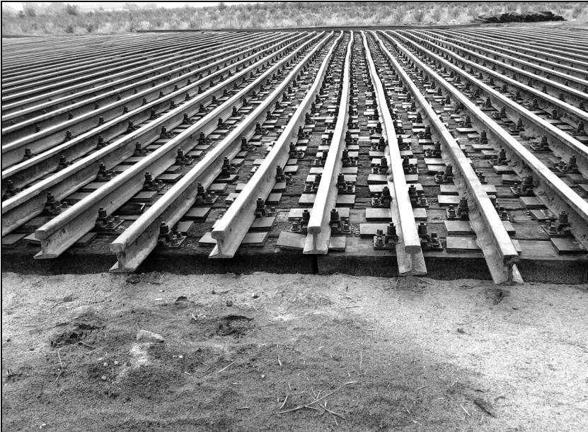
Rys. 5. Budowa pierwszej warstwy zabezpieczenia rurociągów „Przyjaźń” z wykorzystaniem podkładów i szyn kolejowych w celu zredukowania nacisków jednostkowych podczas przejazdu maszyn
