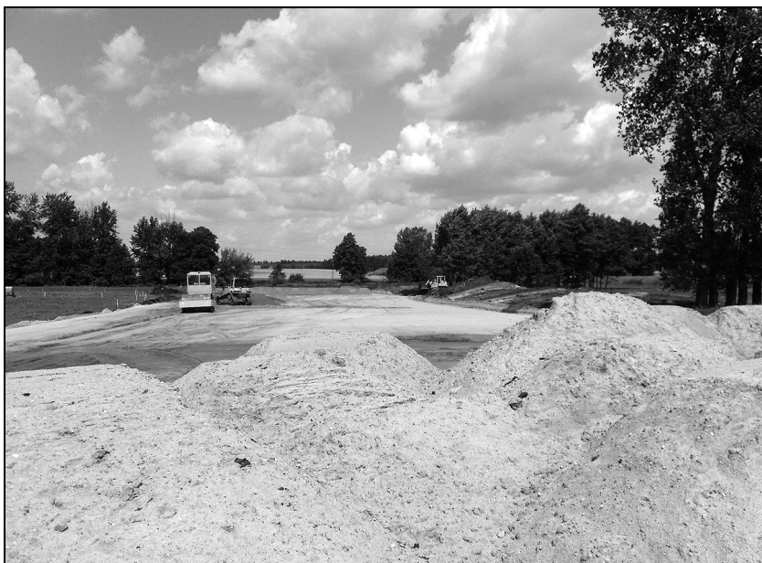
Rys. 4. Prace przy budowie przeprawy maszyn przez rzekę Noteć
