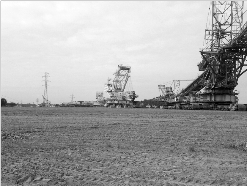
Rys. 3. Przejazd maszyn podstawowych przez zdemontowany odcinek linii energetycznej wysokiego napięcia 110 kV na trasie z odkrywki Lubstów do odkrywki Tomisławice
