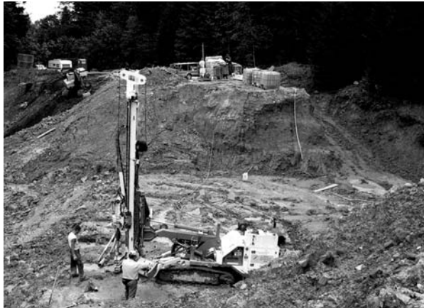
Rys. 4. Wgłębne mieszanie gruntu w podstawie nasypu
