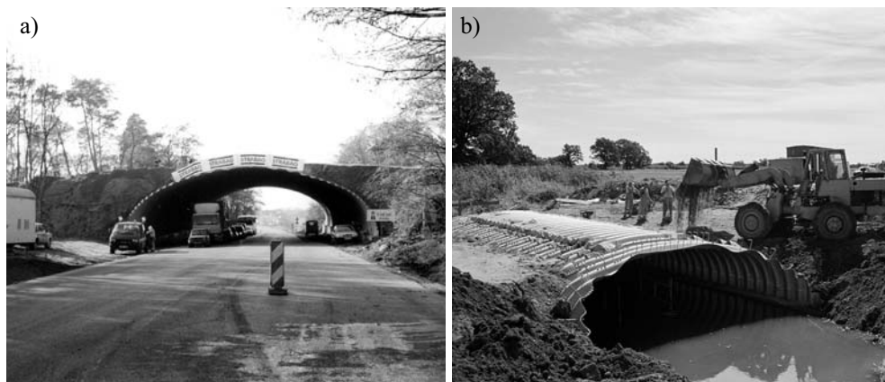
Rys. 1. Przykłady wykonywania zasyпки gruntu wokół powłoki w mostowych konstrukcjach gruntu-stalowych w: a) Trzebiatów, b) Wrocławiu
