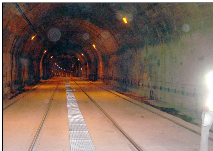
Rys. 14. Zastosowanie systemów EBS oraz ERS firmy Edilon z matami wibroizolacyjnymi pod płytą podtorową w tunelach metra w Madrycie
