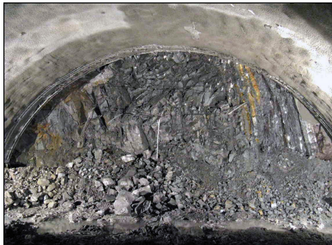
Rys. 2. Zdjęcie przodka tunelu na 280,6 m tunelu
