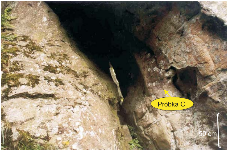
Fig. 5. Szczelina z widocznymi skorupami będącymi efektem wietrzenia płytowego
