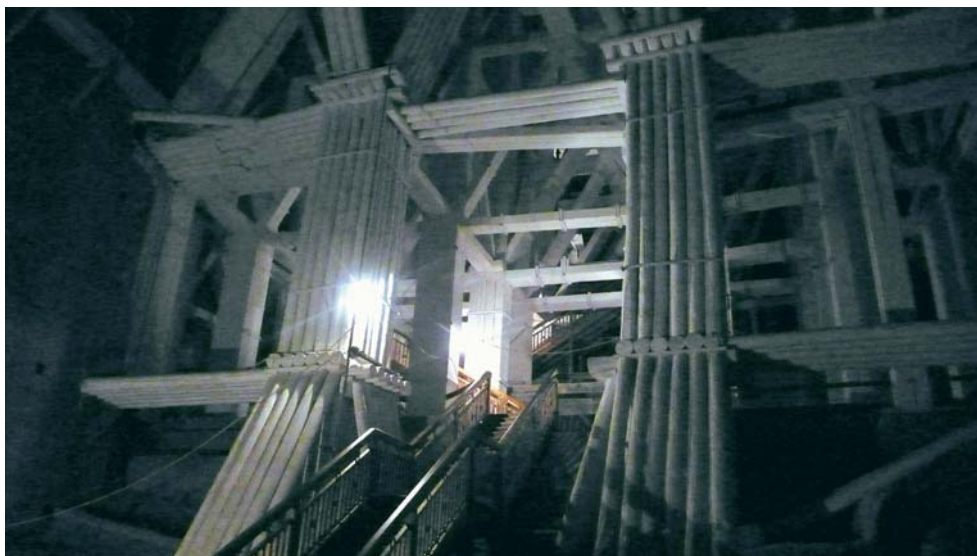
Fig. 11. Komora Michałowice – wygląd po zakończeniu prac zabezpieczających, 2009 r.
