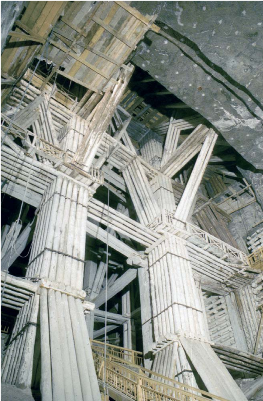
Fig. 9. Komora Michałowice podczas prac zabezpieczających w latach 90. XX wieku. Widoczna siatka kotwienia niskiej, wschodniej partii stropu
