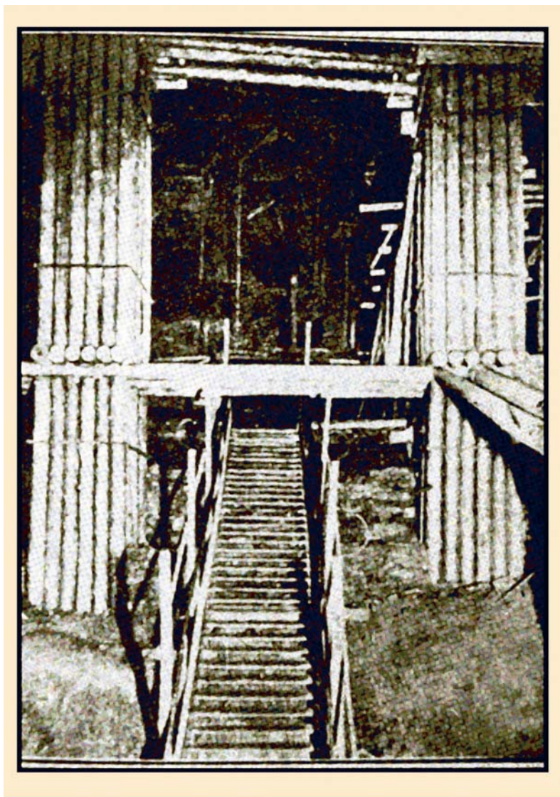
Fig. 7. Komora Michałowice w pierwszych latach XX wieku podczas budowy kolejnych elementów obudowy podporowej (widoczne rusztowania i pomosty). Fot. Jan Czarnecki, 1903
