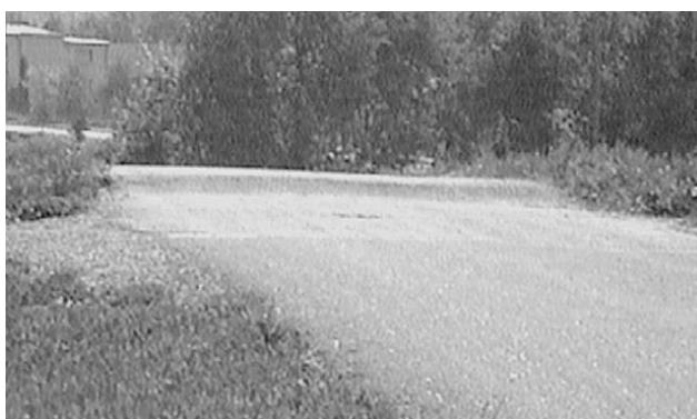
Rys. 8. Próg powstały w wyniku odprężenia górotworu (prawdopodobnie w rejonie uskoku)
