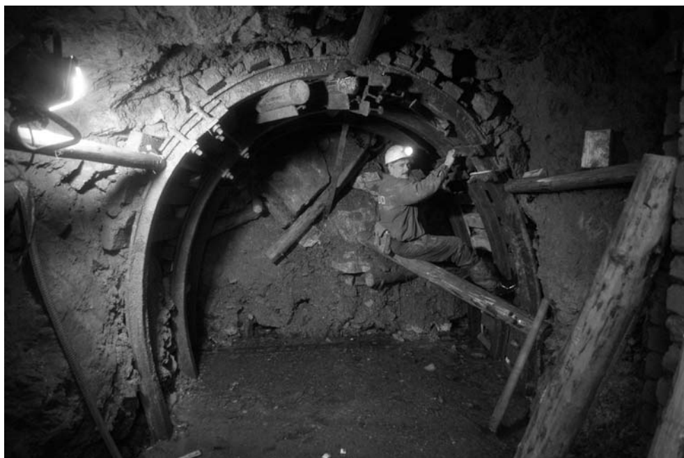
Rys. 6. Roboty górnicze przy przebudowie sztolni Czarnej Dolnej (fot. J. Gruźlewski, 2006)
