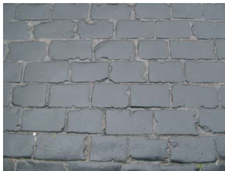
Fig. 9. Bruk z bazaltowej kostki rzędowej z Wołynia na ul. Szewskiej
