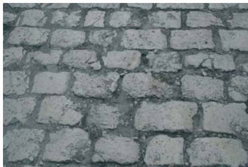
Fig. 2. Nawierzchnia ułożona z kostki górnourajskiego wapienia na ul. Gołębiej
