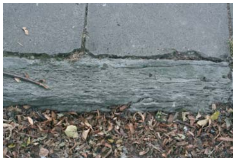
Fig. 11. Zniszczony procesem wietrzenia krawężnik z karpackiego piaskowca godulskiego przy ul. Kraszewskiego
