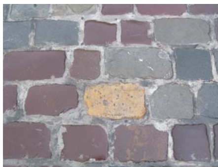
Fig. 8. Fragment nawierzchni placu przed Dworcem Głównym PKP z wymieszanego bruku z porfiru, piaskowca karpackiego, andezytu pienińskiego i dolomitu diploporowego
