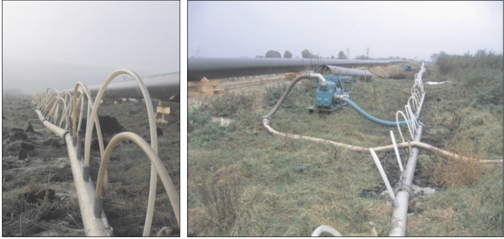
Rys. 8. Widok dwustronnego drenażu odwadniającego w postaci igłofiltrów na trasie przebudowy gazociągu (fot. Marek Galas)
