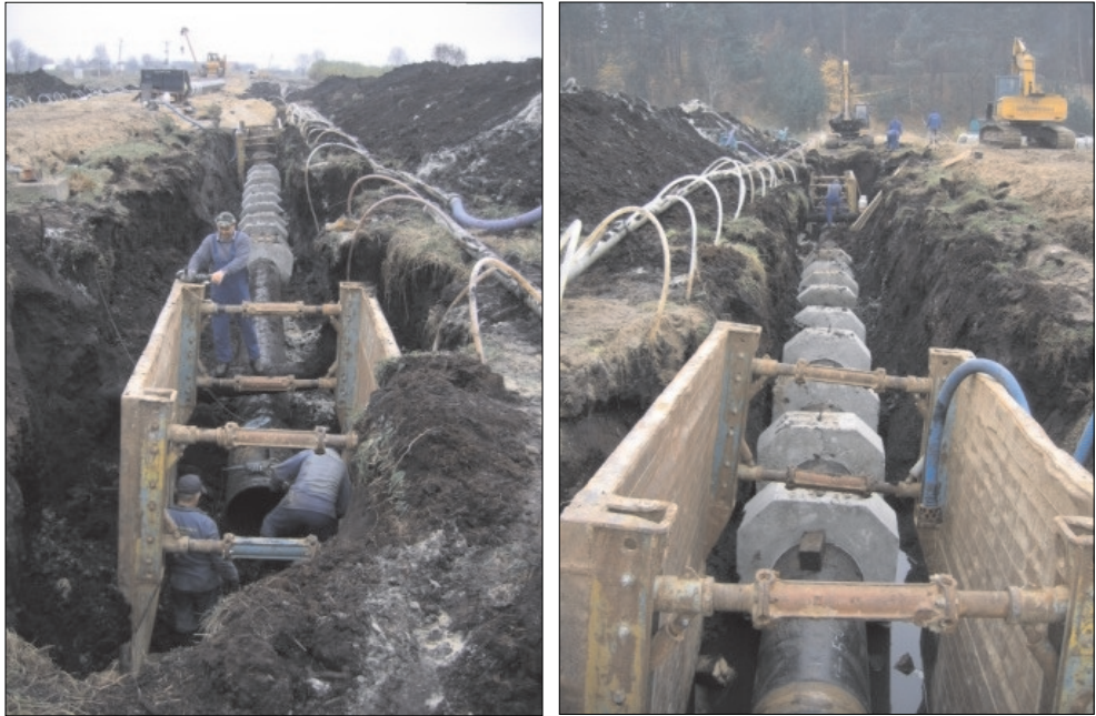
Rys. 10. Widok realizacji przebudowy odcinka gazociągu (fot. Marek Galas)
