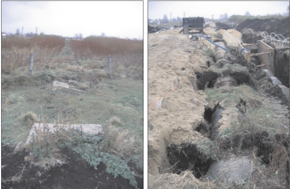
Rys. 9. Widok wypłyenia istniejącego gazociągu przed realizacją i w trakcie przebudowy po ściągnięciu obciążników (fot. Marek Galas)
