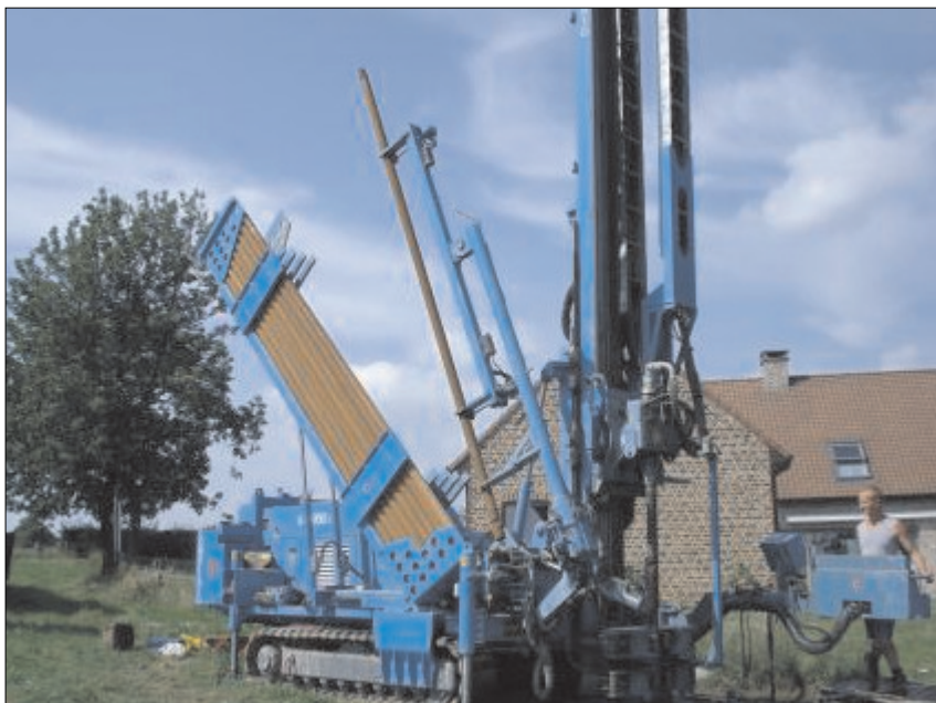
Rys. 4. Automatyczny podajnik rur płuczkowych wiertnicy Comacchio
