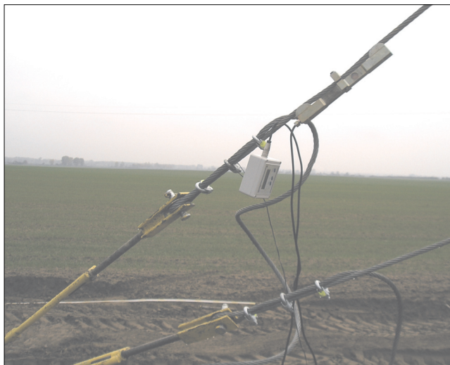
Rys. 3. Pomiar napięcia w linie odciągowej
