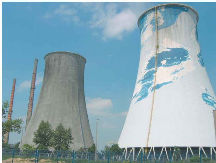
Fig. 2. Kominy Elektrociepłowni KRAKÓW od południowego-wschodu
