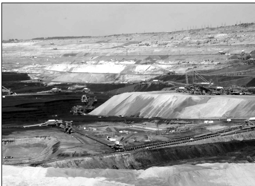
Rys. 3. Widok z I poziomu zwałowiska wewnętrznego na podzwałowanie zbocza północnego
