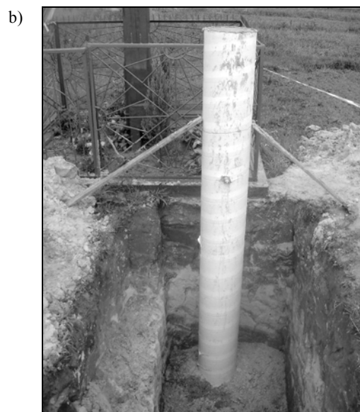
Rys. 1. Stabilizacja punktów kontrolowanego (po lewej) i referencyjnego (po prawej)
