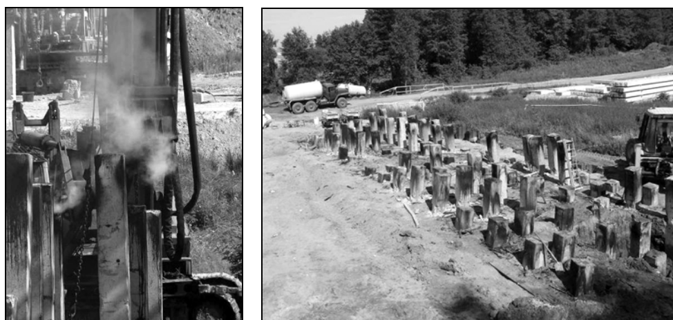
Rys. 8. Posadowienie podpór wiaduktu — problemy z pograżaniem pali
