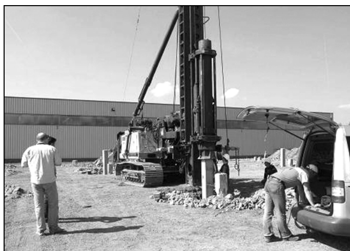
Rys. 2. Stanowisko do badań dynamicznych pali prefabrykowanych
