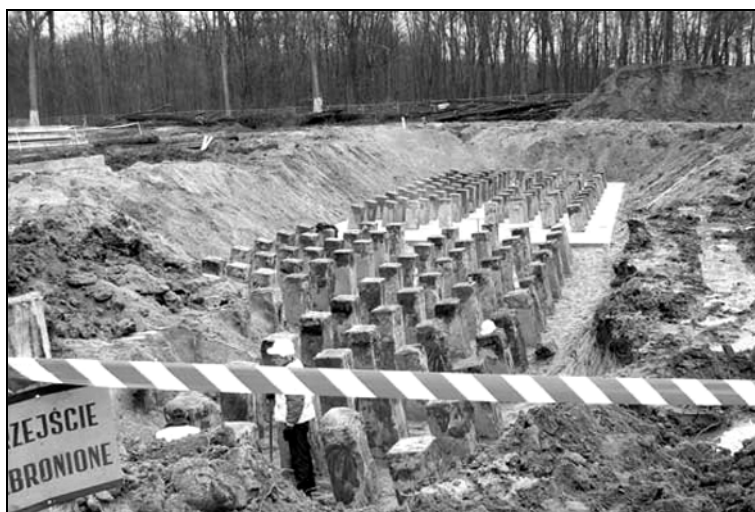
Rys. 5. Fundament palowy pod przyczółek na autostradowej obwodnicy Wrocławia
