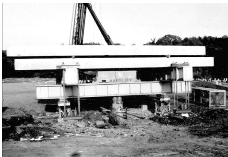
Rys. 3. Stanowisko do badań statycznych z wykorzystaniem jako balast pali prefabrykowanych
