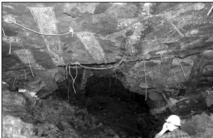
Rys. 3. Dojście do przodka pasa P-73a
