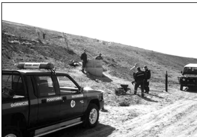
Rys. 7. Studnia udostępniająca górną część obudowy tunelu C wydrążona w zaprzeze zbiornika
