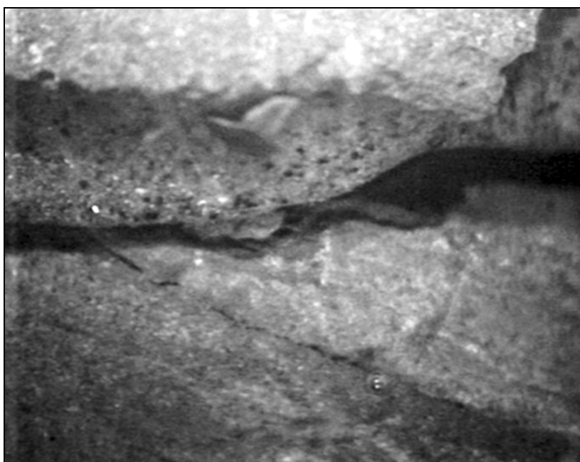
Rys. 2. Przykładowy obraz szczeliny w ścianie otworu wiertniczego
