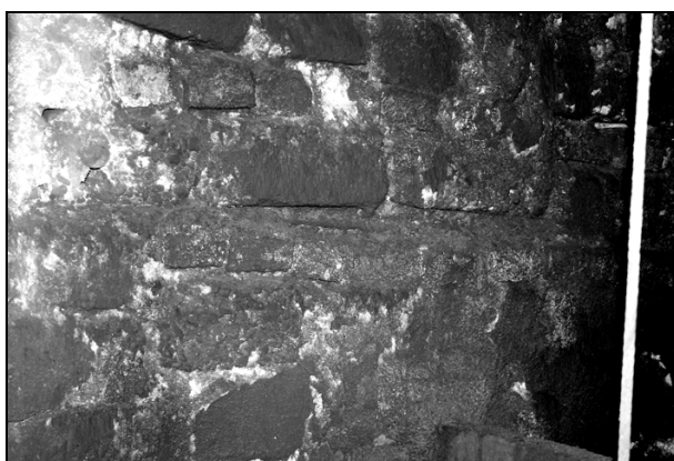
Rys. 1. Fragment obudowy wykonanej z cegły na poziomie dźwigara nr 123
