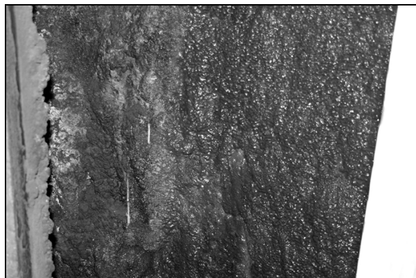
Rys. 2. Stan obudowy na poziomie dźwigara nr 123
