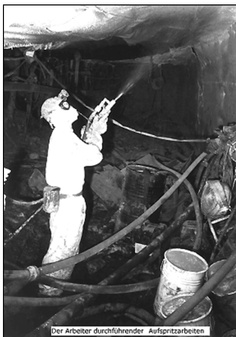
Rys. 3. Natrysk elastycznej żywicy organiczno-mineralnej
