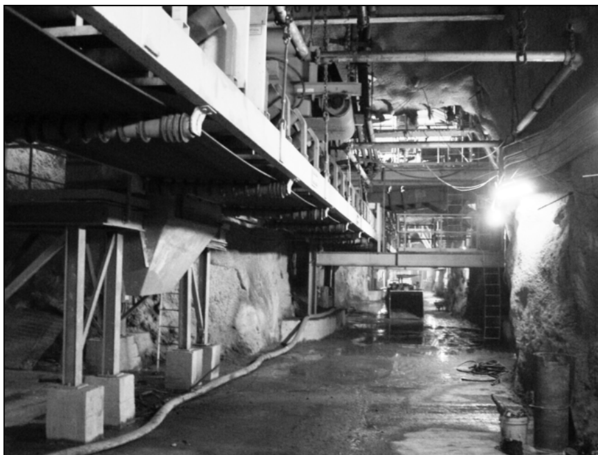
Rys. 4. Poziom 570 — główny przekop przenośnikowy
