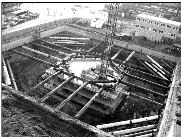
Rys. 6. Widok rozparcia ścian szczelinowych z jego oparciem na centralnym fragmencie konstrukcji apartamentowca w Poznaniu
