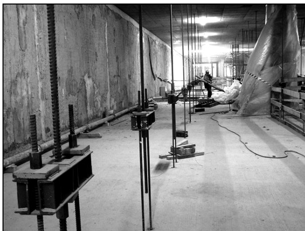
Rys. 3. Rząd odprężonych wieszaków po podparciu stropu pośredniego słupami na stacji metra A19 „Marymont”
