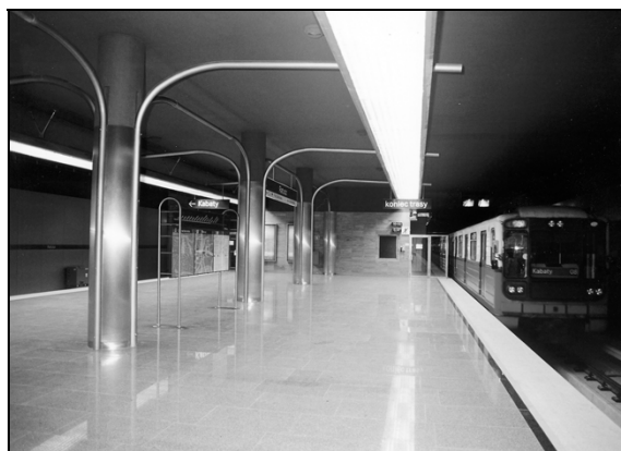
Rys. 1. Widok hali peronowej stacji metra warszawskiego A15 „Ratusz”
