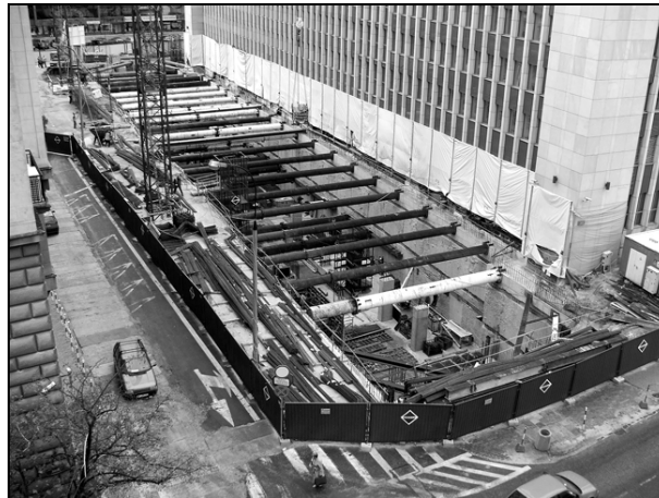
Rys. 7. Wykop pod część podziemną budynku NSA w Warszawie w sąsiedztwie budynku istniejącego
