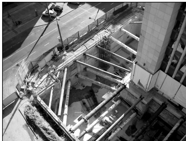
Rys. 8. Rozparcie ścian szczelinowych w narożniku wykopu pod budynek NSA w Warszawie
