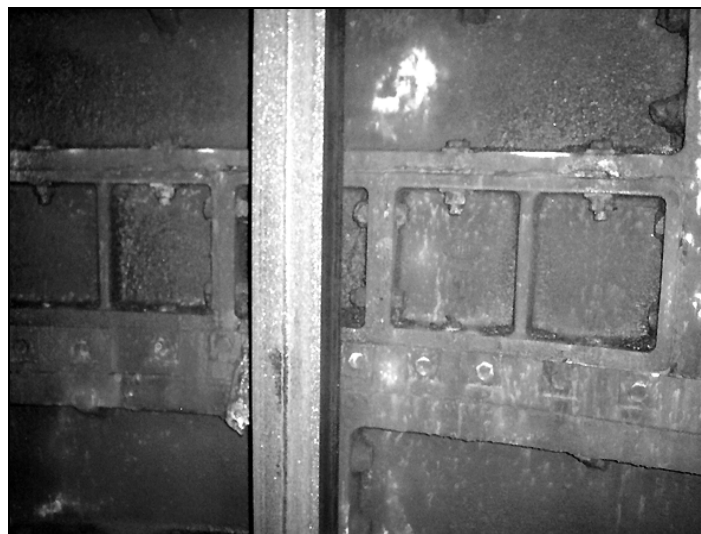
Rys. 12. Wkładka trójdzielna wbudowana w przestrzeń międzyżebrową uszkodzonego segmentu tubingowego
