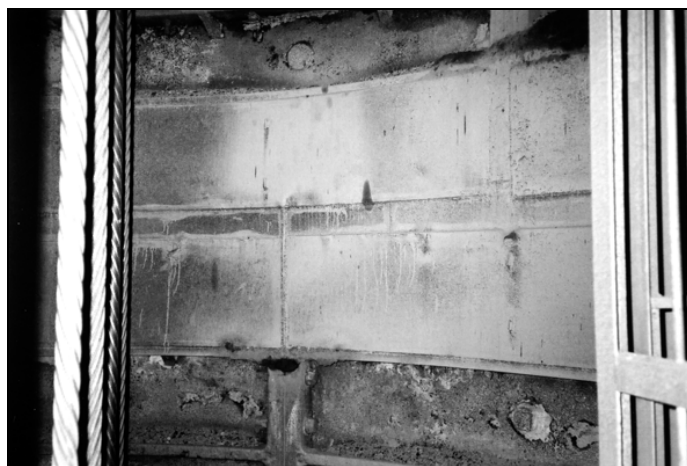
Rys. 9. Naprawiona obudowa tubingowa szybu L-II w rejonie szczeliny pikotażowej nr 8
